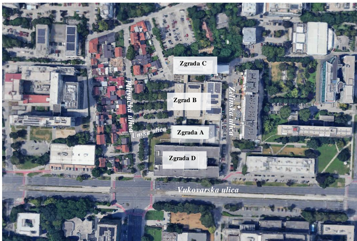
Slika 13. Građevine i infrastruktura u neposrednoj blizini zgrade A
